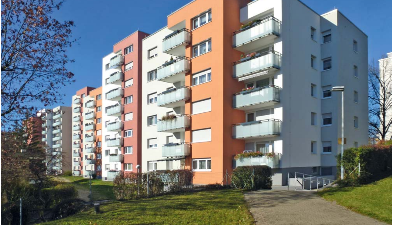
Rückseite Rohrdommelweg 2–12 (vorher und nachher)
