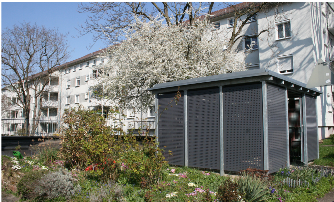
Unsere Mieter freuen sich über mehrere neue Müllhäuser im Wohngebiet Badbrunnen .
