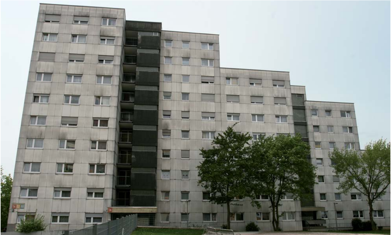
Marabastraße 12 und 14 vor der Modernisierung
