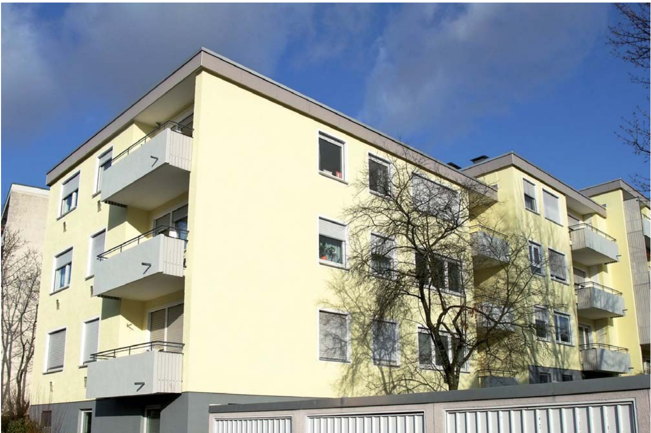
Der Baumannweg 10, 12 erstrahlt in neuem Glanz
